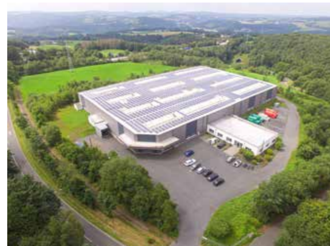
PV-Anlage auf der Produktionshalle in Neustadt/Wied
